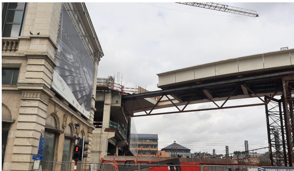
Figure 103 Rampe d'accès en travaux ( Source : Tractebel, 30 septembre 2020)
