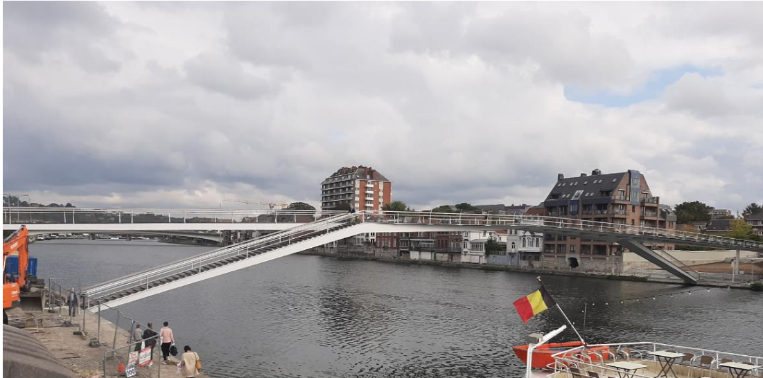
Figure 31 Passerelle "l'Enjambée" déjà empruntée après inauguration (Source : Tractebel, 30 septembre 2020)
